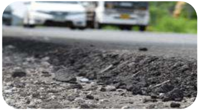
Materiale per sottofondo stradale
